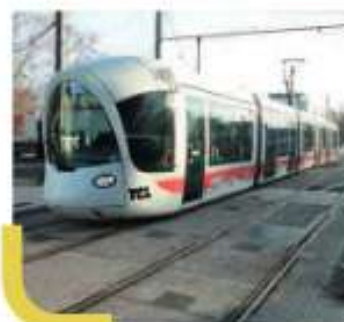
Chantier Lyon : un réseau de tram en pleine expansion
